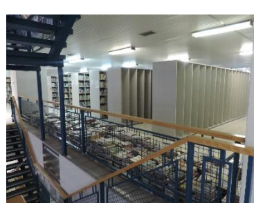
Rekonštrukcia úseku odb. literatúry
