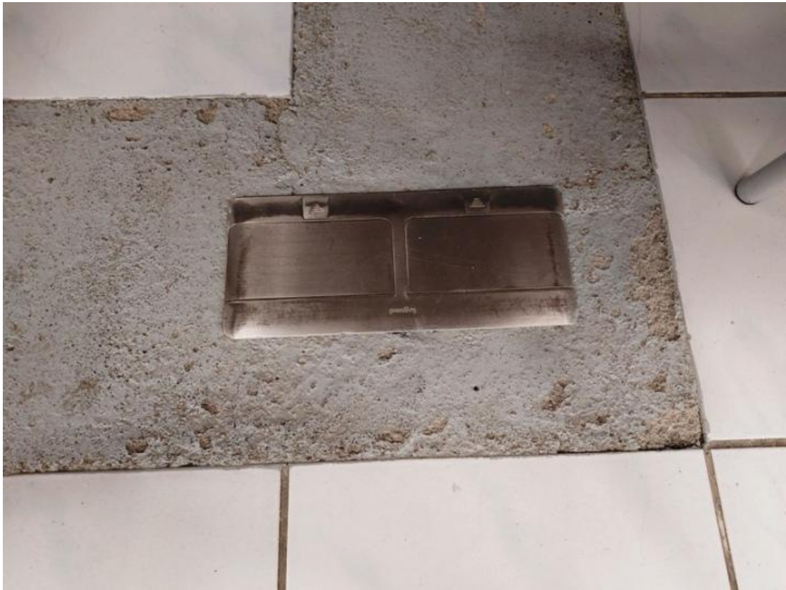
Obrázok 1 Podlahové zásuvkové krabice musia byť rozmerovo, funkčne a vizuálne kompatibilné s existujúcimi podlahovými zásuvkovými krabicami.
