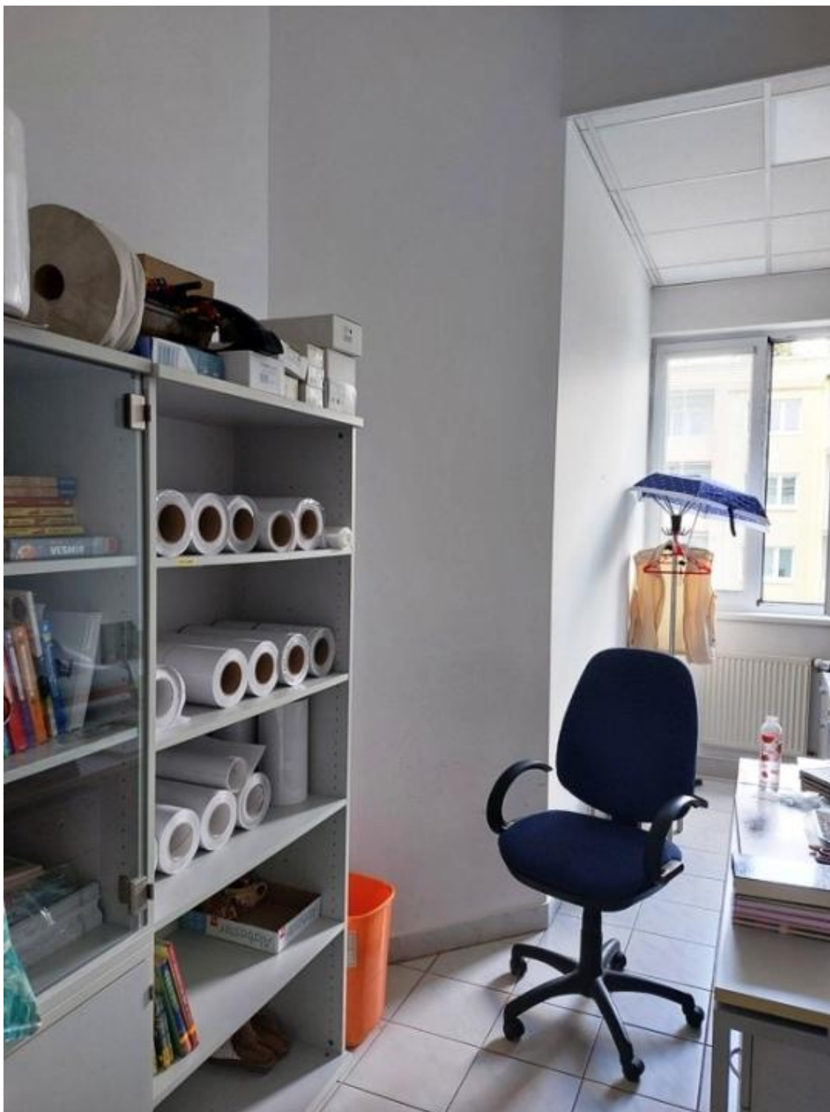
Obrázok 5: Podateľňa – pohľad na existujúcu lomenú priečku určenú na demontáž v rámci realizácie stavebných prác.
