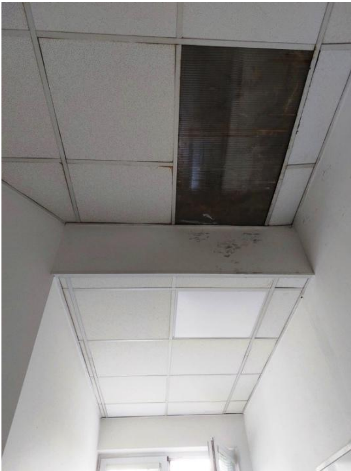
Obrázok 6: Podateľňa – pohľad na strop s existujúcim svetlíkom v rámci existujúcej konštrukcie
