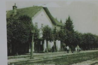
„Rajecká Anča“ a železničná stanica v minulosti
