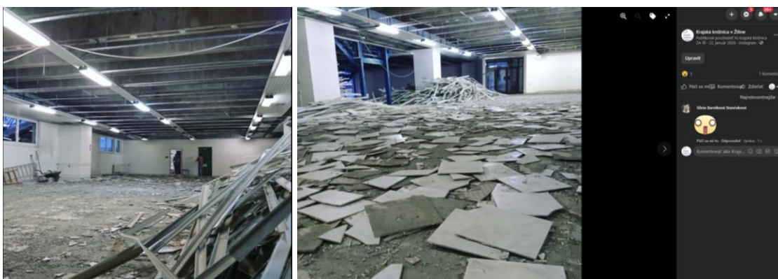
Obrázok 15 Rekonštrukcia prízemia Krajskej knižnice v Žiline
